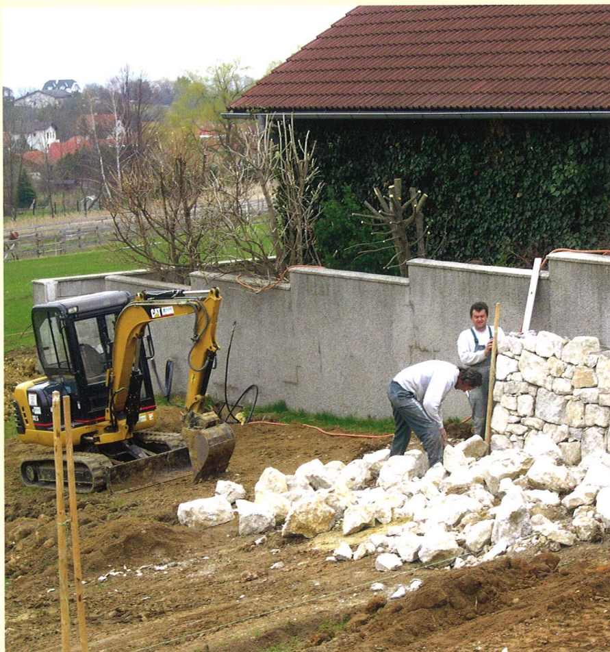
Hangterrassierung unter Einsatz von Cat-Minibagger und -Lader, Blazek Baustelle im südlichen Niederösterreich
