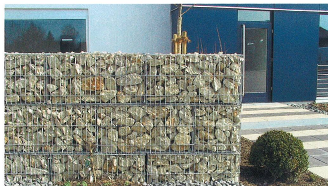
Auch mit moderner Architektur harmonieren die Rawe-Steinkörbe
