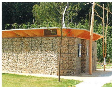
Komplette Bauwerke mit originellen Fassaden lassen sich mit Steinkörben realisieren
