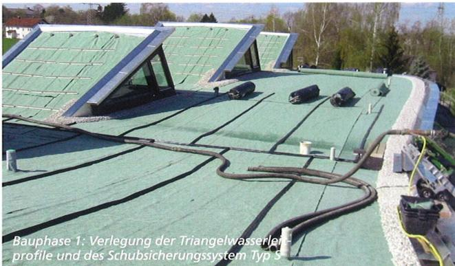
Bauphase 1: Verlegung der Triangelwasserlaufprofile und des Schubsicherungssystem Typ 5
