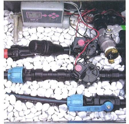
Ventilkasten: Easy fit Steckverbindungen für den Tropfschlauch (Rainbird) sind bis zu einem Druck von 4 bar dicht.
