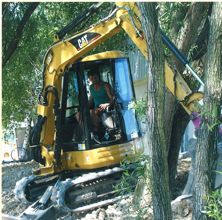
Baggerfahrer Rudolf Ducke mit dem CAT 305 CR auf engstem Raum im Einsatz.
