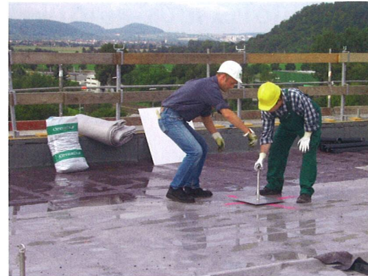
Schnell und einfach zu verlegen: OPTISAFE ... zuerst die Grundplatte ...
