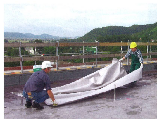
... das Sicherheitsvlies kommt noch drauf ...
