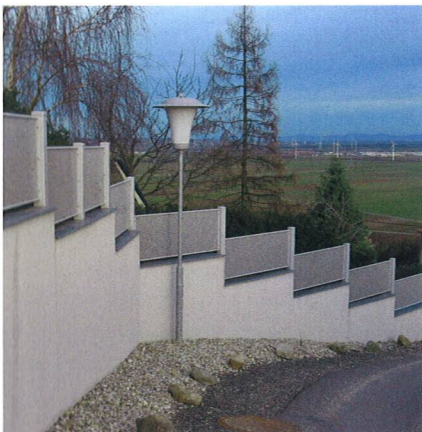
Steile Lösungen: Zaunverlauf im Gelände
