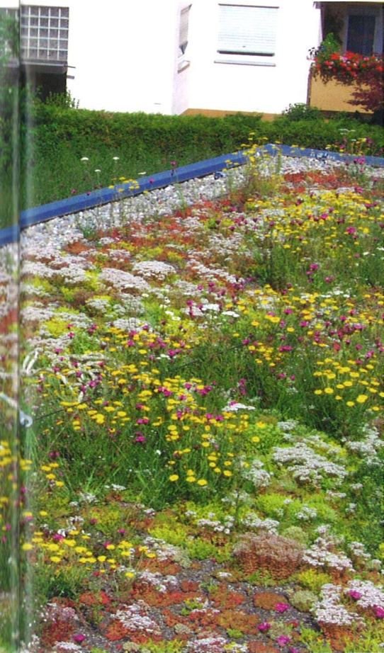
Sichere Pflege und Wartung der Dachbegrünung
