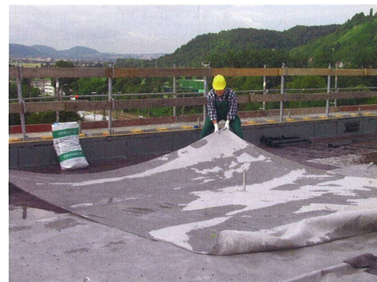
... fertig: es fehlt noch die Auflast und Sicherung durch den Gründachaufbau
