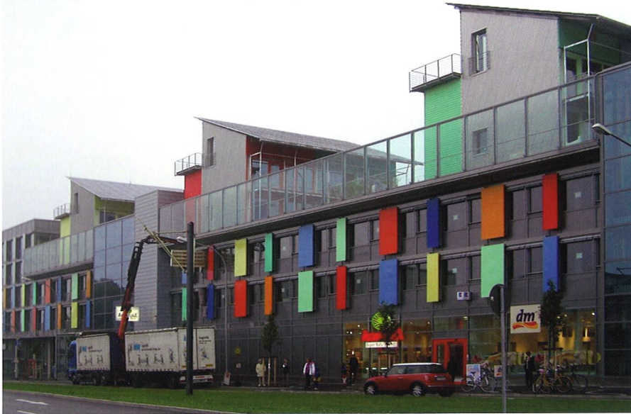
Fassade Merzhauser Straße nach Fertigstellung
