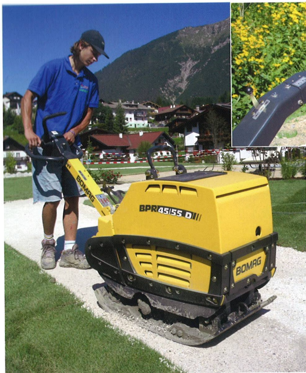
Neben Robustheit und Qualität legt man bei Bomag auch auf Sicherheit großen Wert: Auto-Stopp-Taste in Bauchhöhe
