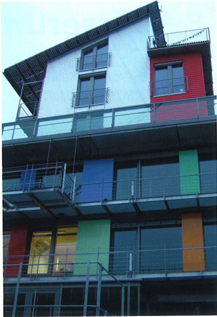
Rückseitige Fassade mit Penthaus
