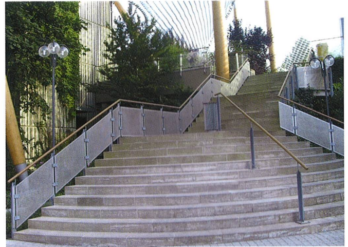
Beständig gegen Frost und Tausalz: Treppenanlage aus fränkischem Muschelkalk.
