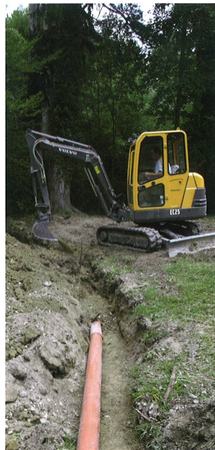
Volvo EC25B beim Verlegen eines Abflussrohres
