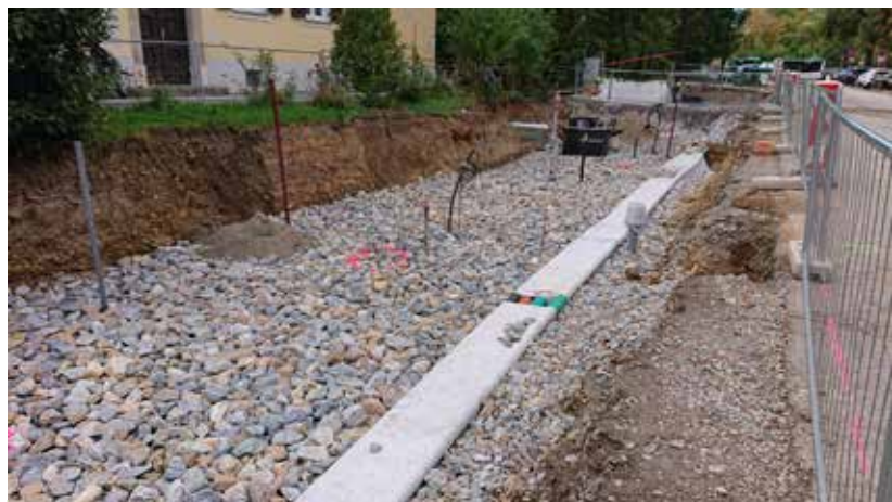
Leonhardgürtel West während der Bauphase; Grobschlag vor der Einschlämmlung des Feinmaterials; im Leitungspaket sind Bestandsleitungen; zudem wurden Kabel, Rohre und Schläuche für Messeinrichtungen verlegt.
