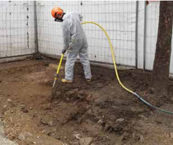
Wurzelfreilegung von Kastanien mittels Luftdruckkanze als Vorbereitung für die Bestandsbaumsanierung mit vorgemischtem Schwammstadtsubstrat.
